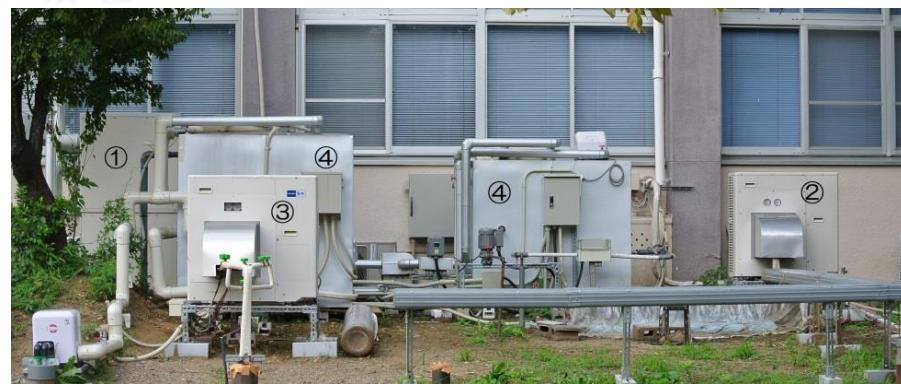
①間接方式GSHP（従来型）④貯湯タンク
