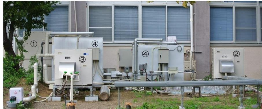
①間接方式GSHP（従来型）④貯湯タンク
