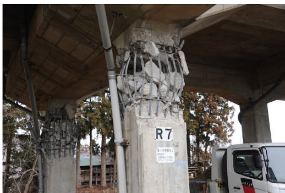
東日本大震災での橋梁の被害の様子
