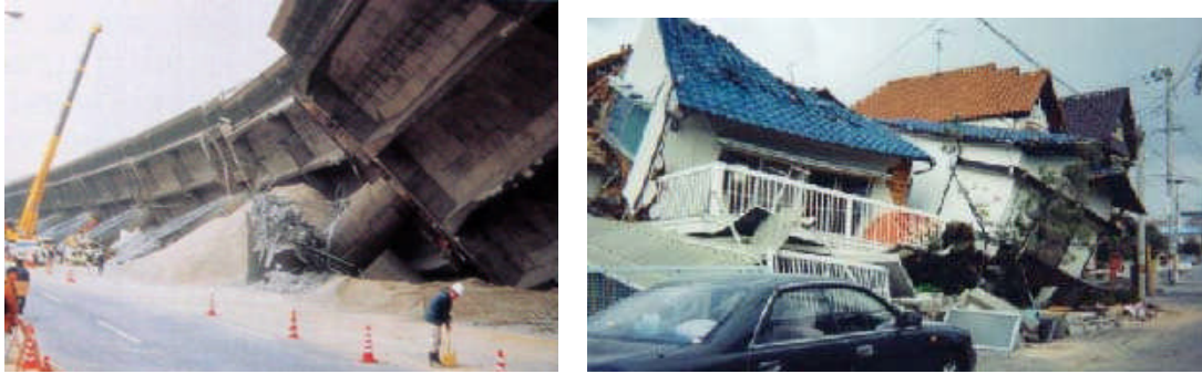
阪神淡路大震災時に橋梁が倒壊した様子
