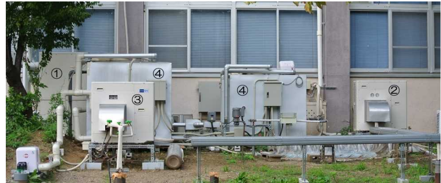
①間接方式GSHP（従来型）④貯湯タンク ②③直接膨張方式GSHP（本ユニットの提案型）
